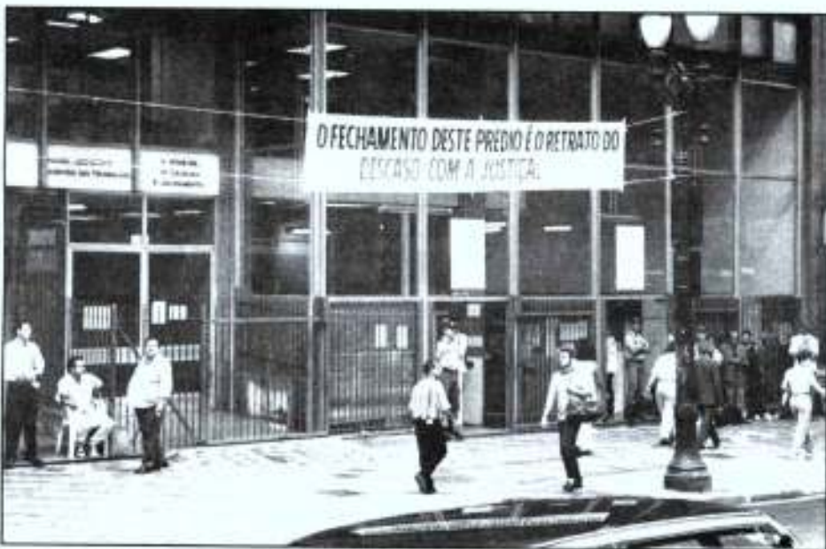
Prédio da Justiça do Trabalho na Av. Ipiranga, em São Paulo, interditado pela Prefeitura
